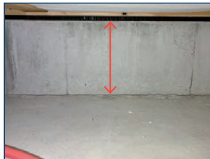
● 床下土間面の基礎箇所
