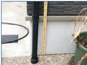
● 外周部の基礎の高さ計測
