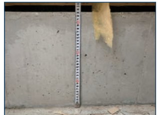
● 床下土間面の基礎の高さ計測
