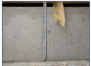
● 床下土間面の基礎の高さ計測
