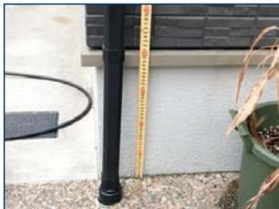
● 外周部の基礎の高さ計測
